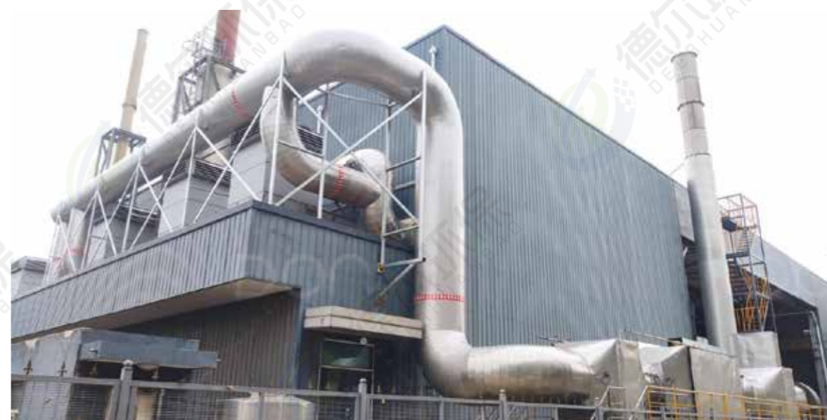
中国兵器集团-柴油发电机组试验台架尾气10万风量净化项目案例
